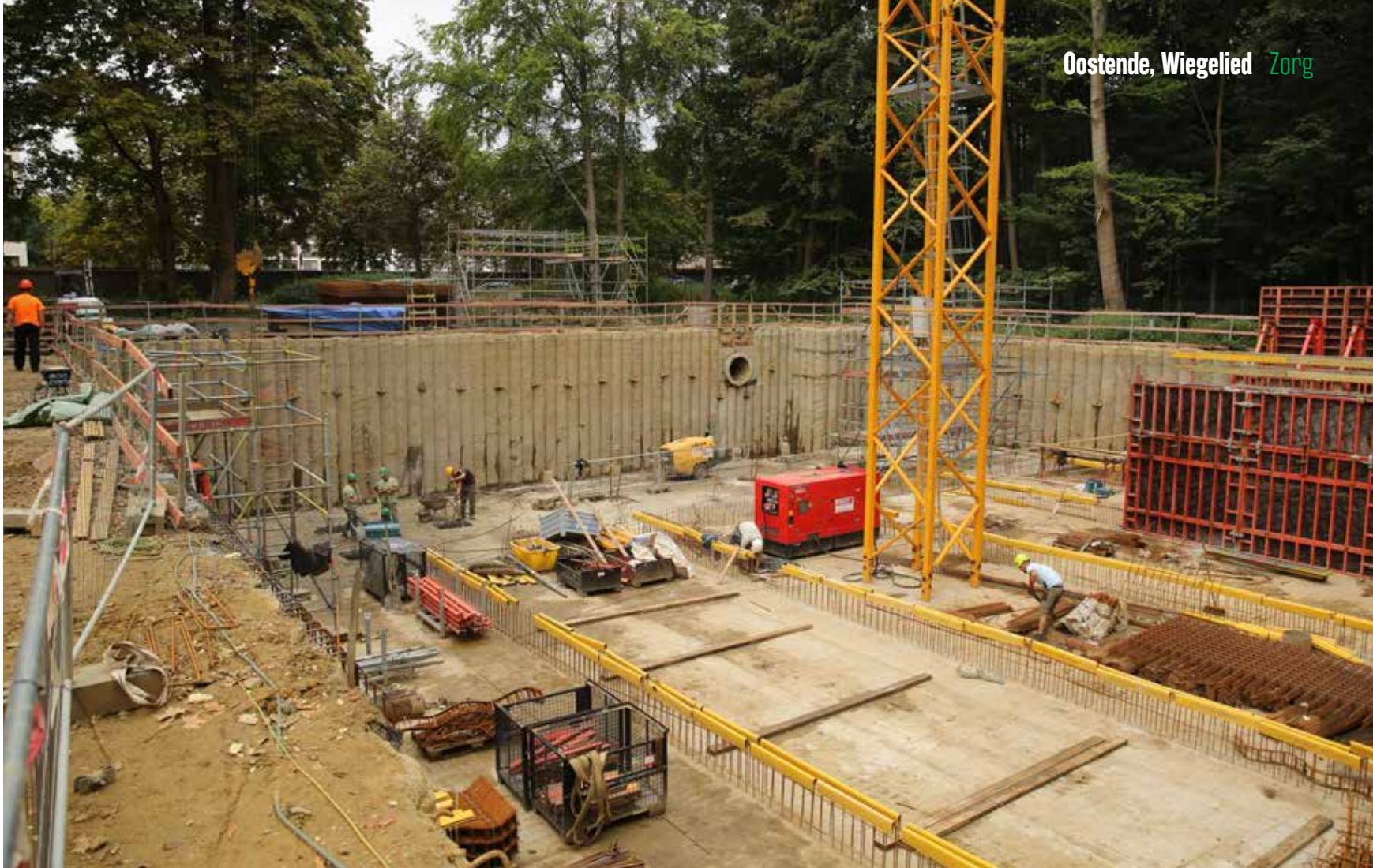
In West-Vlaanderen is de kuststrook globaal genomen minder stabiel qua ondergrond. Vandaar de nood aan een paalfundering.
