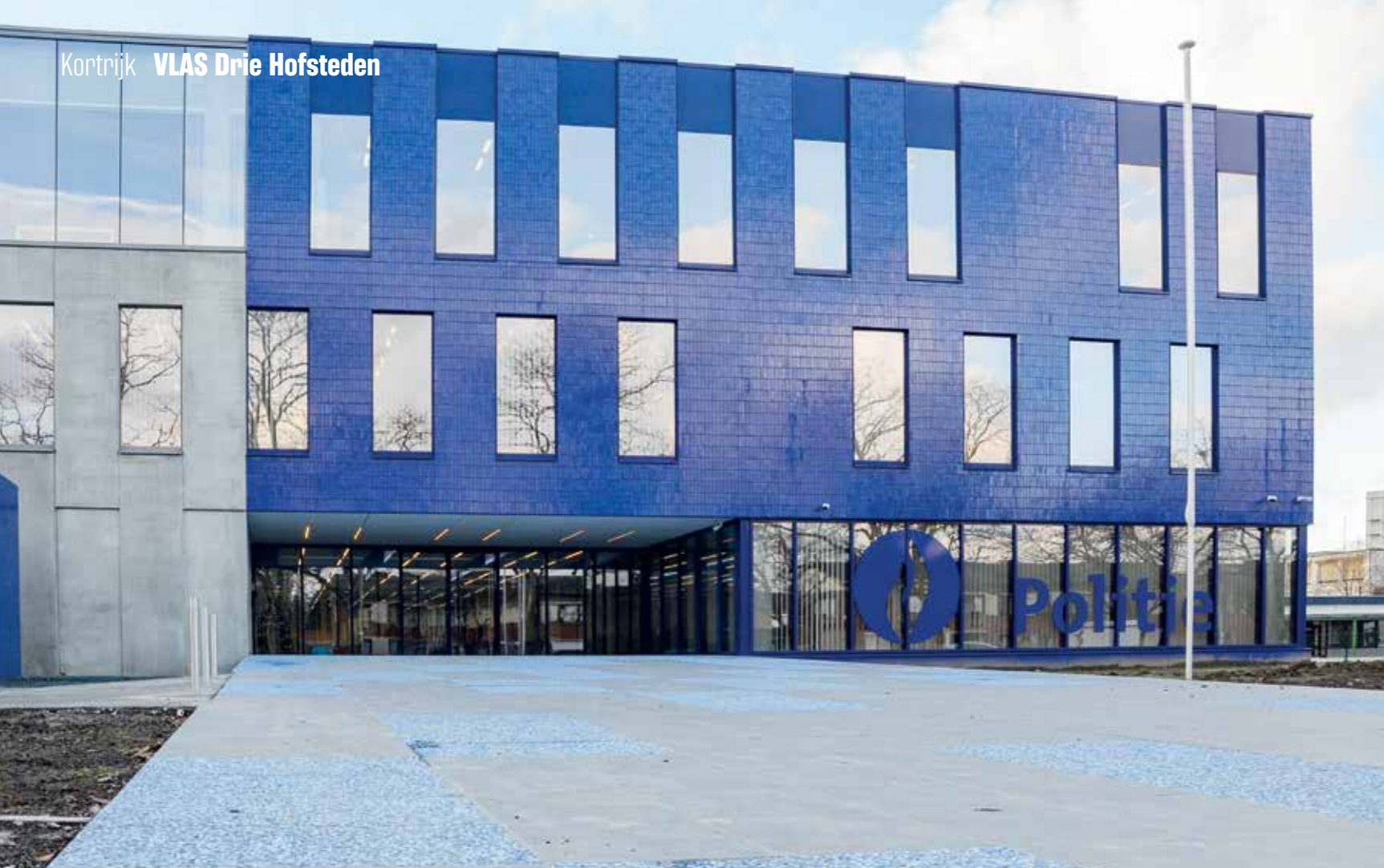
Efficiëntie is de rode draad doorheen het ontwerp van dit nieuwe politiecommissariaat.
