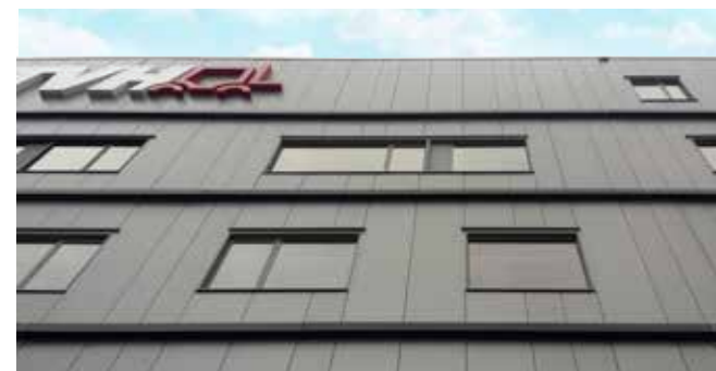
Qua afwerkingsmaterialen kozen we voor een combinatie van donker- en lichtgrijze sandwichpanelen in alu.
