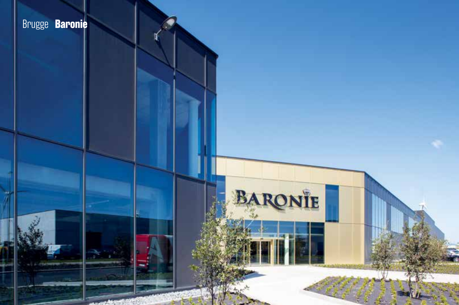
De gevel aan de dwarsgelegen Peraltastraat vormt met zijn spel van open en gesloten vlakken het nieuwe uithangbord van de site.
